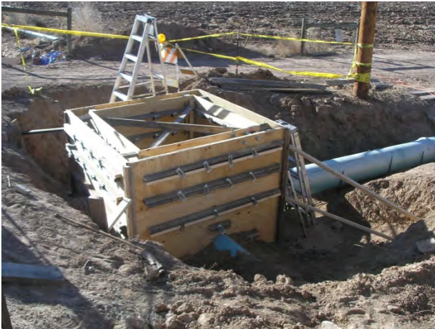
13. Ready to pour the walls and footings!
